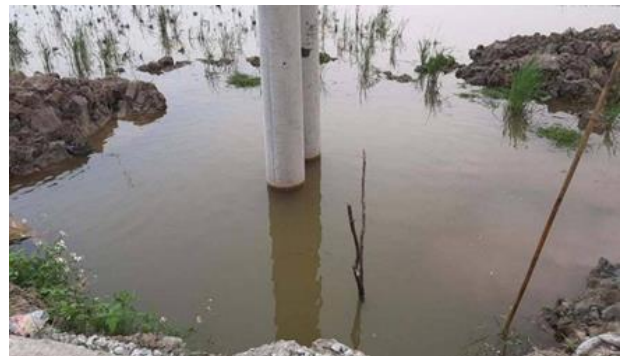
Cống thoát nước công cộng không có nắp đậy, hố chôn cột điện không lấp
